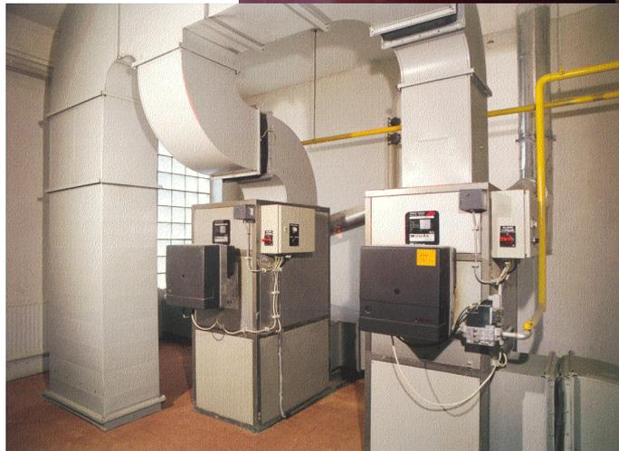
Традиционные чешские газовые нагреватели воздуха МТР имеют широкий спектр применения. Нагреватели, изготовленные нашей фирмой, применяются во всех областях газового нагрева воздуха. Эти нагреватели прямого нагрева воздуха предназначены для подачи и обработки воздуха в вентиляционных и отопительных системах.
